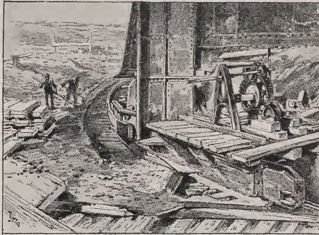
L'ÉVOLUTION DE LA GALERIE DE 30 MÈTRES. — Le treuil moteur monté sur son chariot.
